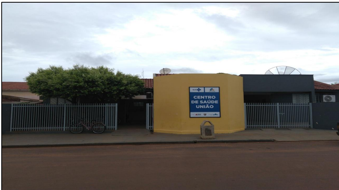
Figura 45: Centro de Saúde União, cidade de União de Minas, MG.
