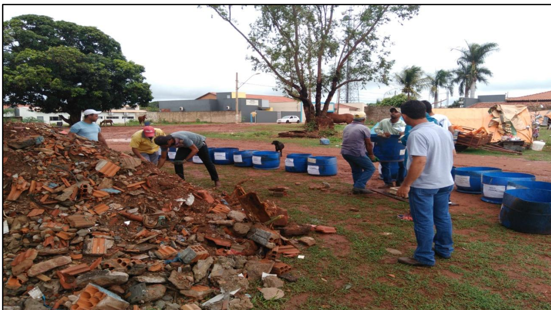
Figura 56: Armazenamento provisório dos resíduos da construção civil e de demolição utilizado na conservação de estradas vicinais do município de União de Minas, MG. Local onde foi realizada a gravimetria desses entulhos.
