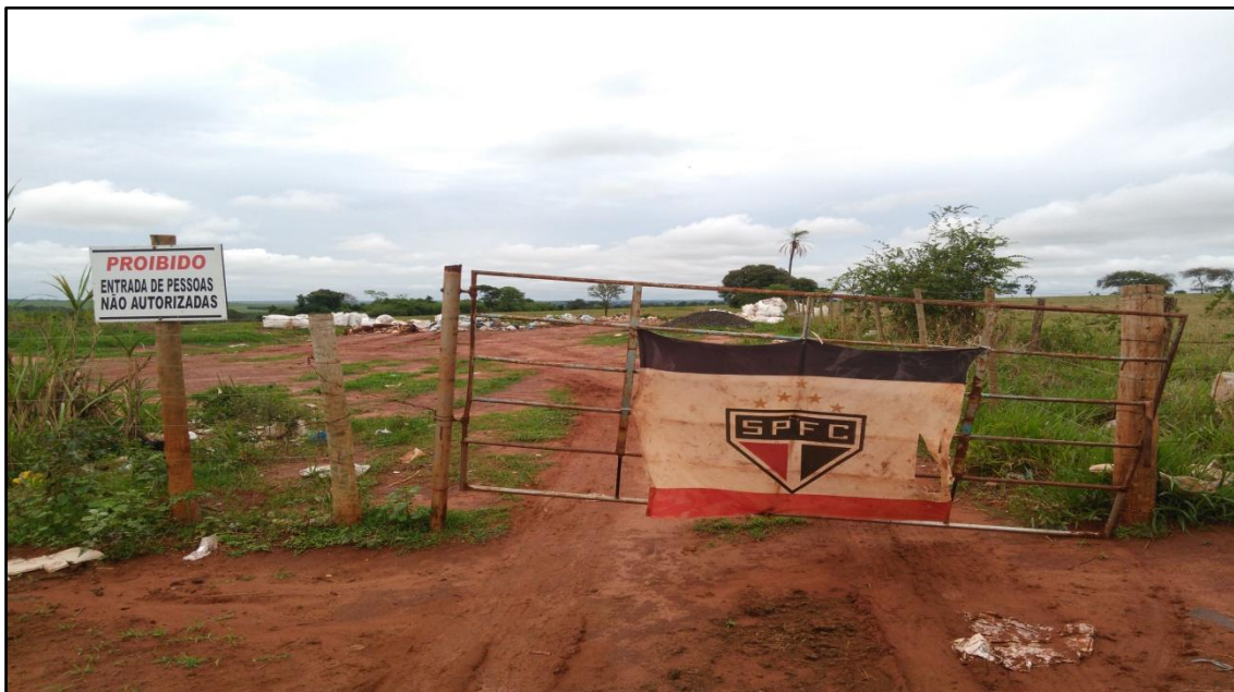
Figura 77: Porteira de ferro e arame de aço inoxidável em seu perímetro para impedir acesso de pessoas não autorizadas na Unidade de Vala Sanitária ativa do município de União de Minas, MG.
