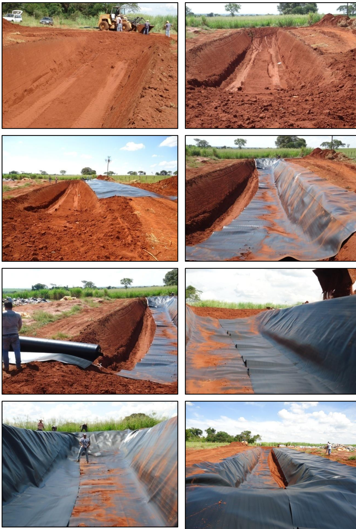
Figura 74: Vala em preparação inicial na Unidade de Vala Sanitária ativa do município de União de Minas, MG.
