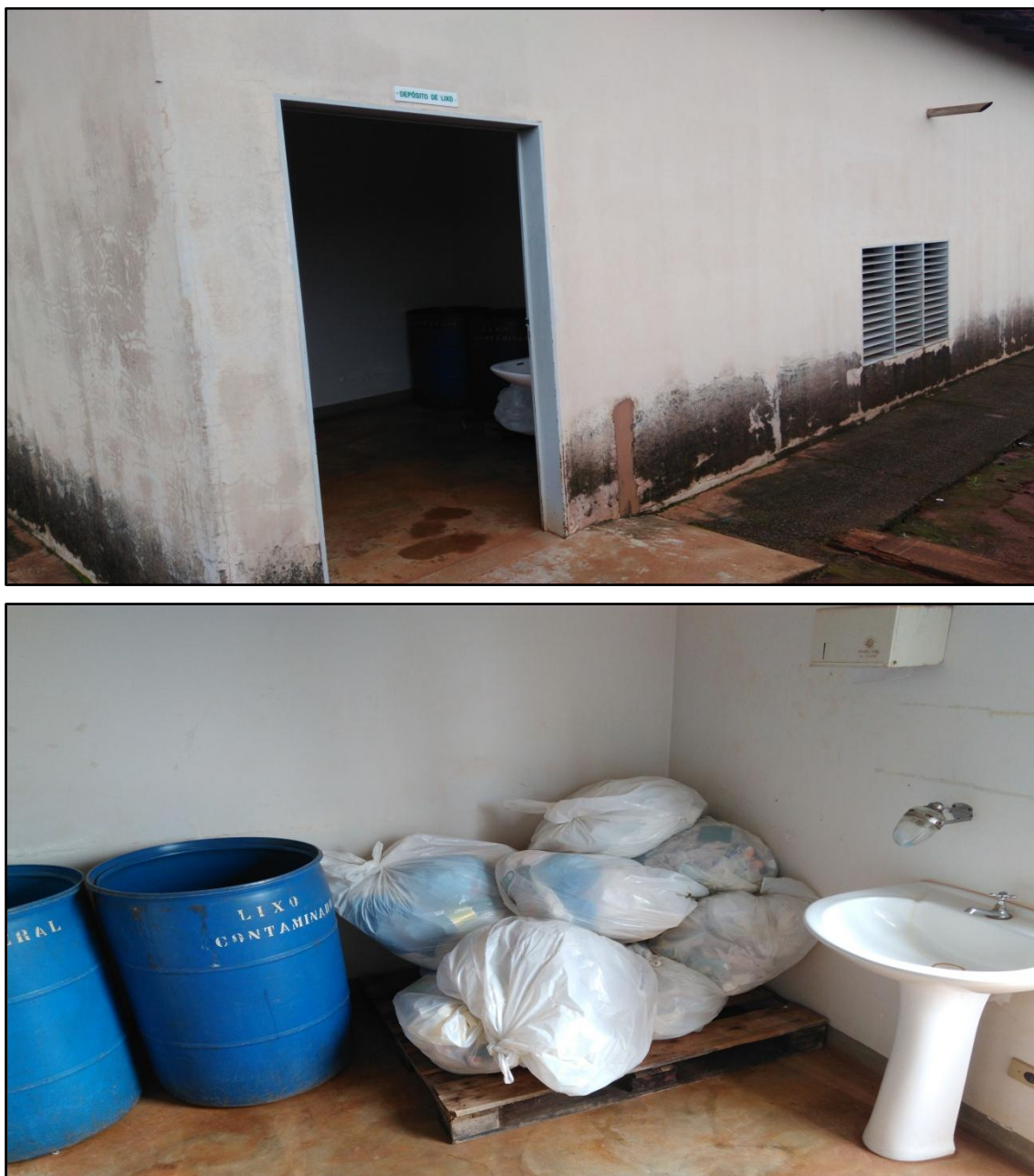
Figura 49: Unidade de transbordo dos resíduos de serviços da saúde na fonte de origem. Unidade filantrópica da Santa Casa de Misericórdia de União de Minas, MG. Ver Figura 44 .
