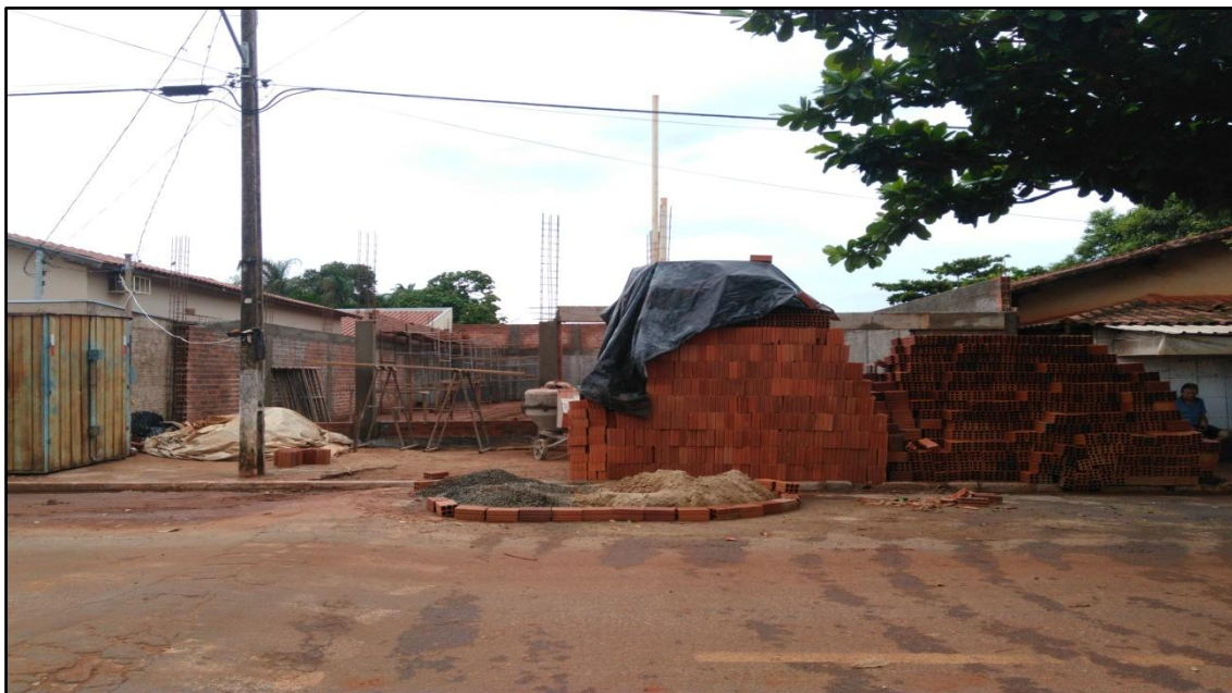
Figura 52: Geradores de resíduos da construção civil e de demolição na cidade de União de Minas, MG.
