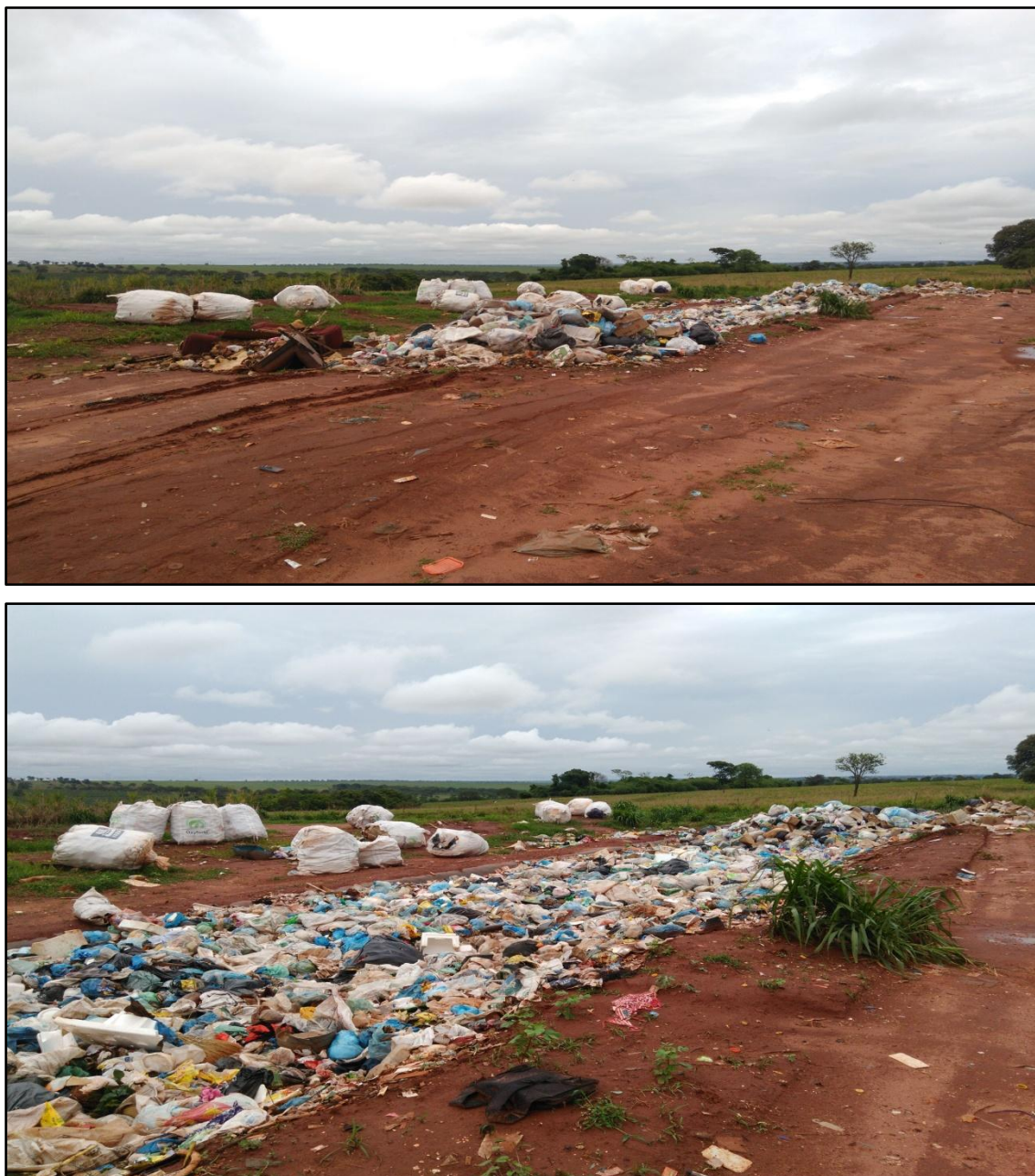
Figura 76: Valas de disposição final de resíduos sólidos na Unidade de Vala Sanitária ativa do município de União de Minas, MG.
