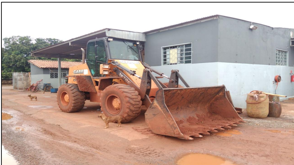
Figura 55: Trator pá carregadeira utilizada na limpeza dos resíduos de construção civil e de demolição na cidade de União de Minas, MG.
