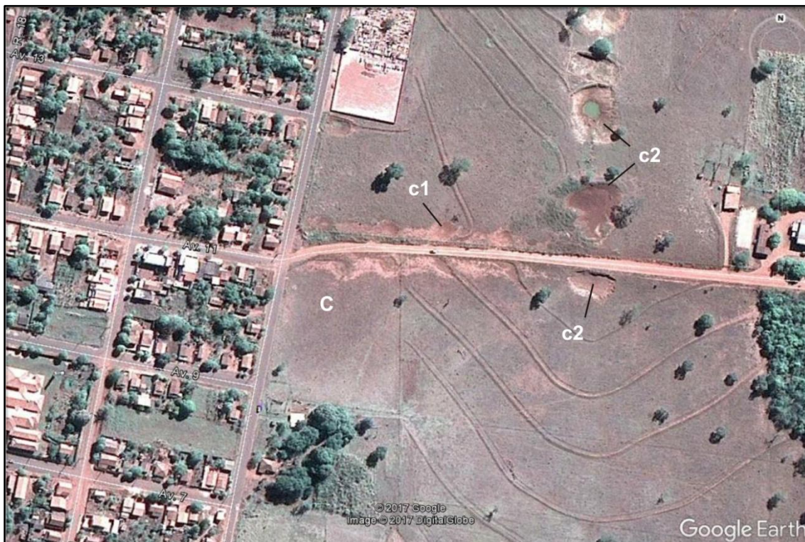
Figura 84: Unidade “Bota Fora” no município de União de Minas, MG (C); processos erosivos avançados (c1); processos erosivos e afloramento do freático (c2).
