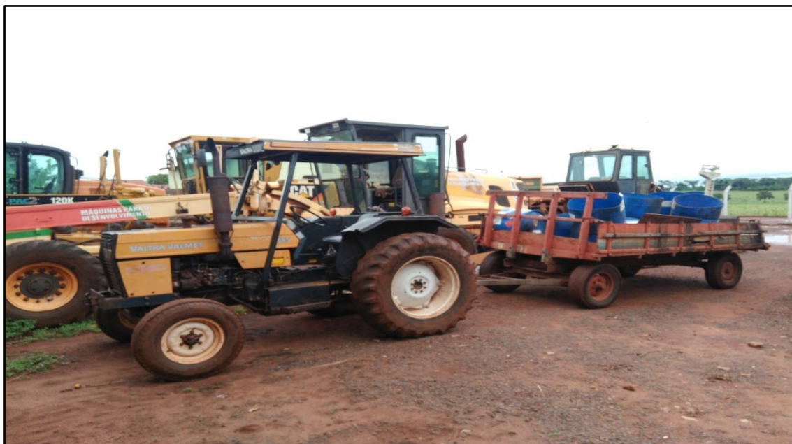
Figura 54: Trator e carreta móvel utilizada no acondicionamento, armazenamento e transporte dos resíduos de construção civil e de demolição em União de Minas, MG.
